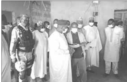
Le ministre Souley Amadou Sarkin Rafi recevant des explications sur le chantier de construction du bloc administratif de l'université Boubacar Bâ
