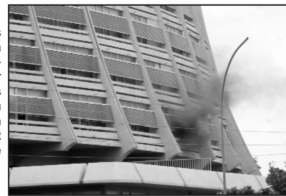
La partie touchée par l'incendie
